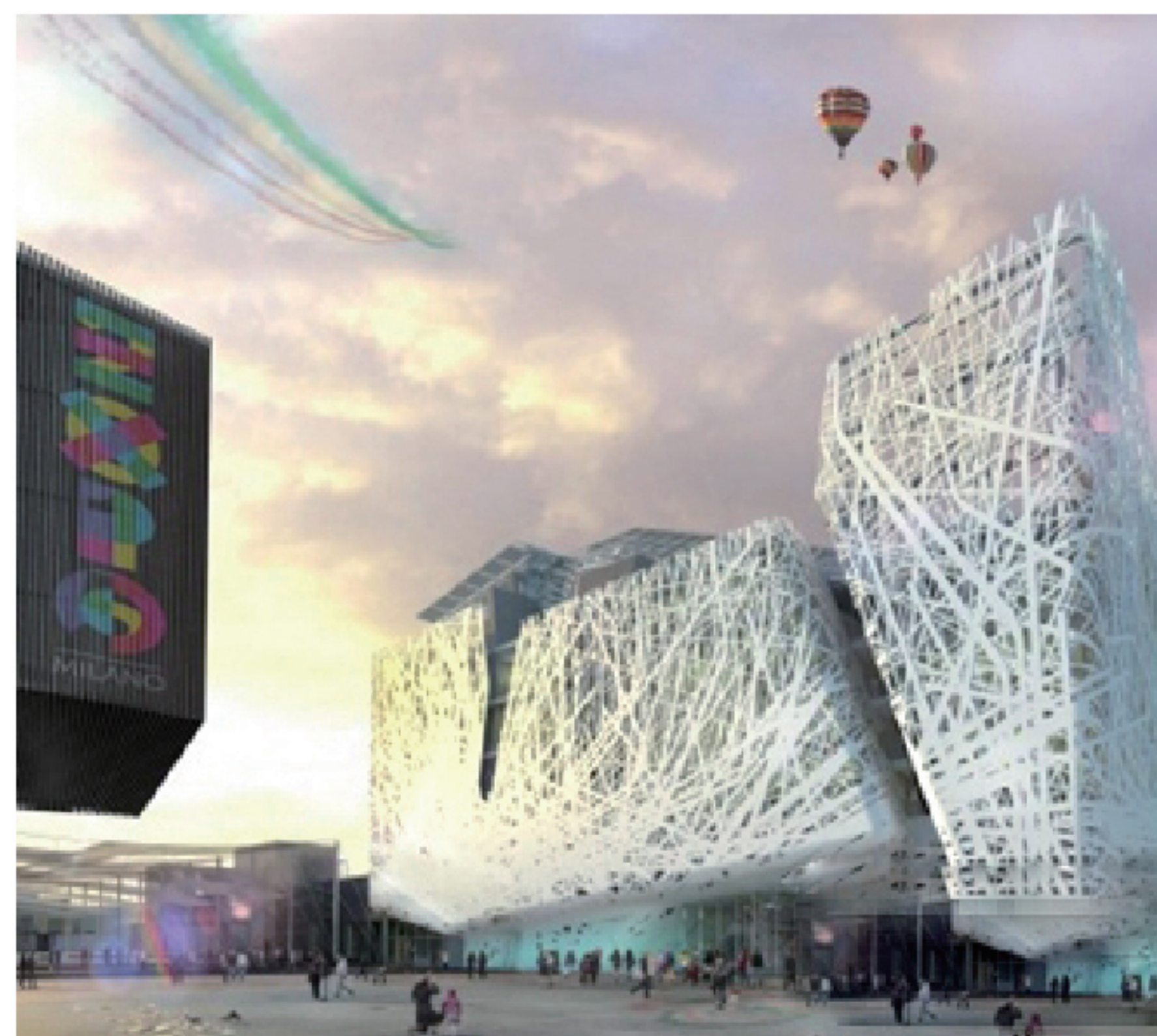
意大利馆将环保做到了极致，外墙安装了能够利用太阳辐射发电的光伏玻璃，能够为周边供电，场馆白色外墙用特殊水泥做成，可吸附空气污染。
